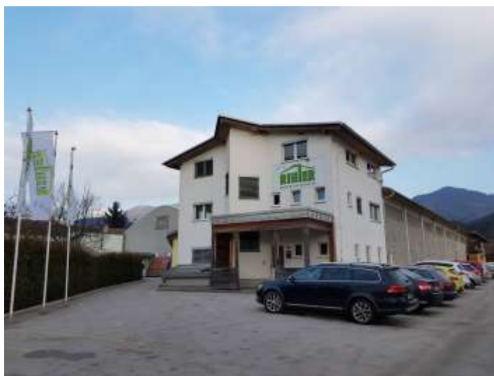
Poslovna zgradba podjetja RIHTER d.o.o. na Ljubnem ob Savinji
